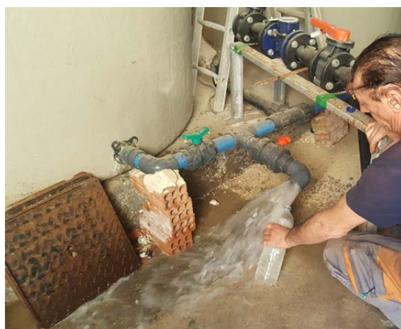
Figura 14. Recogida muestra de agua en el depósito al que se bombean las aguas procedentes del nuevo sondeo, y que desde ahí son distribuidas al balneario.
