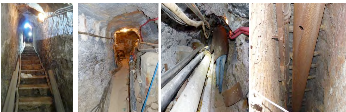
Figura 4. Acceso a la galería donde se sitúan los sondeos de captación números 14 y 23.
