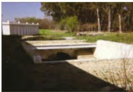
Figura 2.- Acceso al lodo del fondo del arroyo y casita con estancias abiertas “solarium” para el secado al sol
