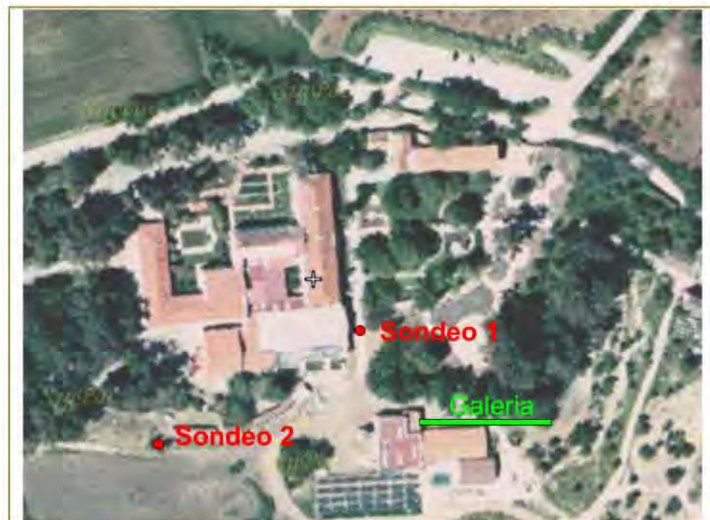
Figura 5.- Captación de aguas minero-medicinales.
