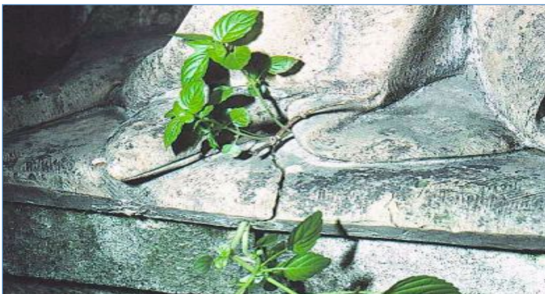
Figura 2.- Daños producidos por plantas en una estatua de terracota de la Puerta del Perdón, Catedral de Sevilla, en el año 1990.
