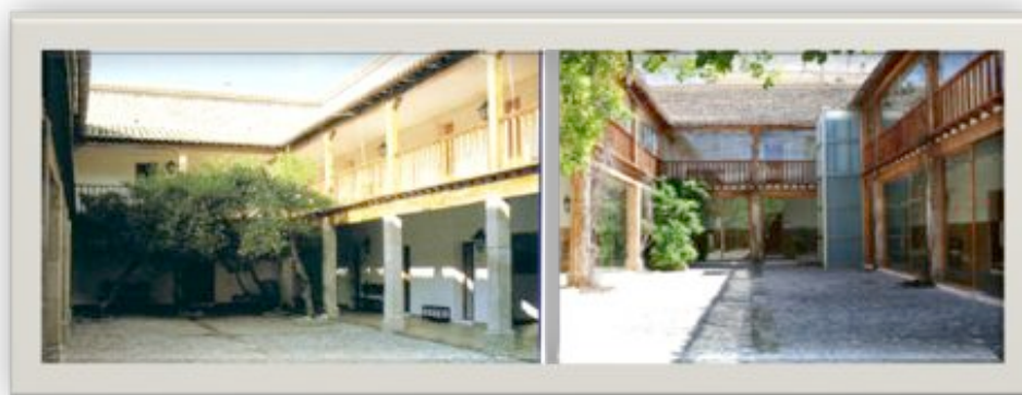
FIGURA 9. EDIFICIO LA MANCHUELA ANTES Y DESPUÉS DE LA REMODELACIÓN EN 2007.
