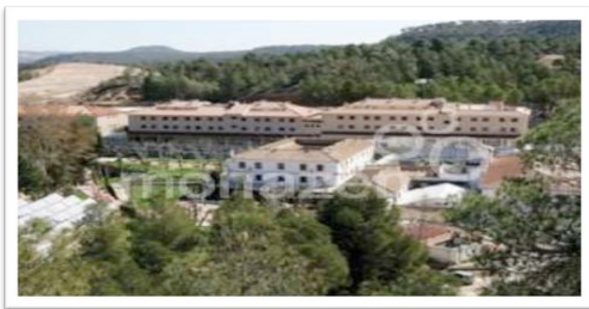
FIGURA 8. VISTA GENERAL DEL BALNEARIO.
