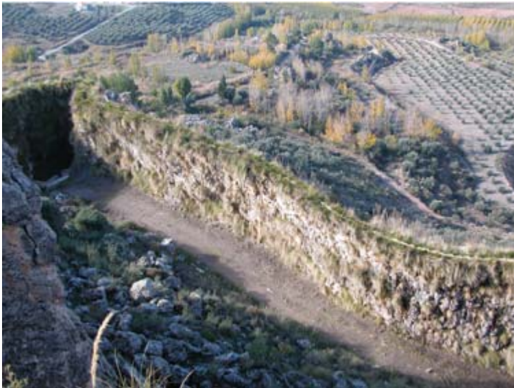
Figura 11. Acequia del Toril junto al Balneario de Alicún de las Torres.
