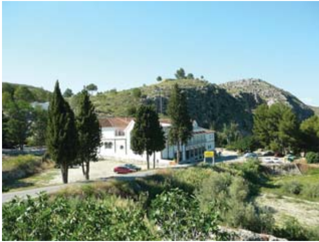
Figura 1. Edificios del Balneario.
