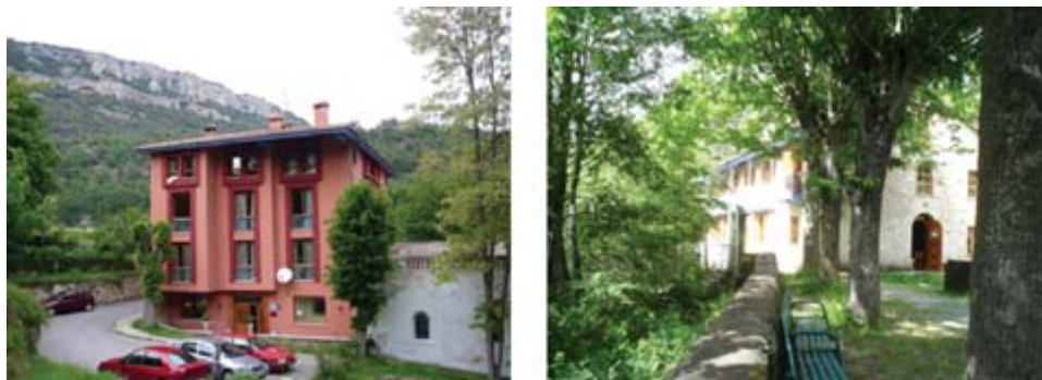
FIGURA 1. Edificios del Balneario. Fachadas principal y posterior.
