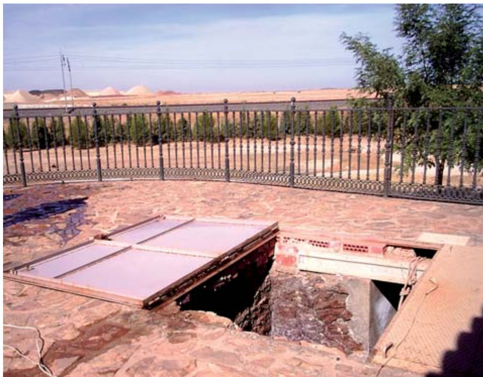
FIGURA 1. Manantial Cervantes. Punto de emergencia.
